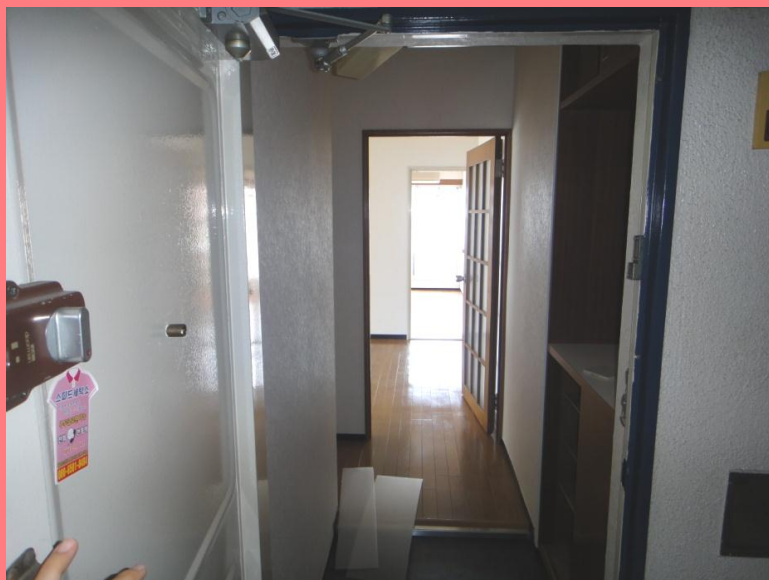
【エントランス】before
